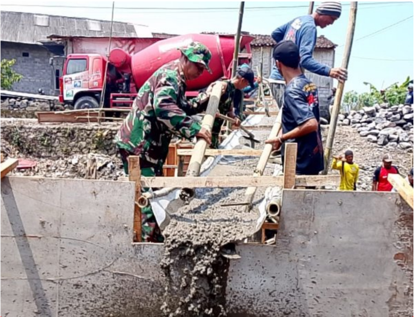
(Foto Dokumen) : TNI dan warga gotong royong bangun pondasi jembatan
