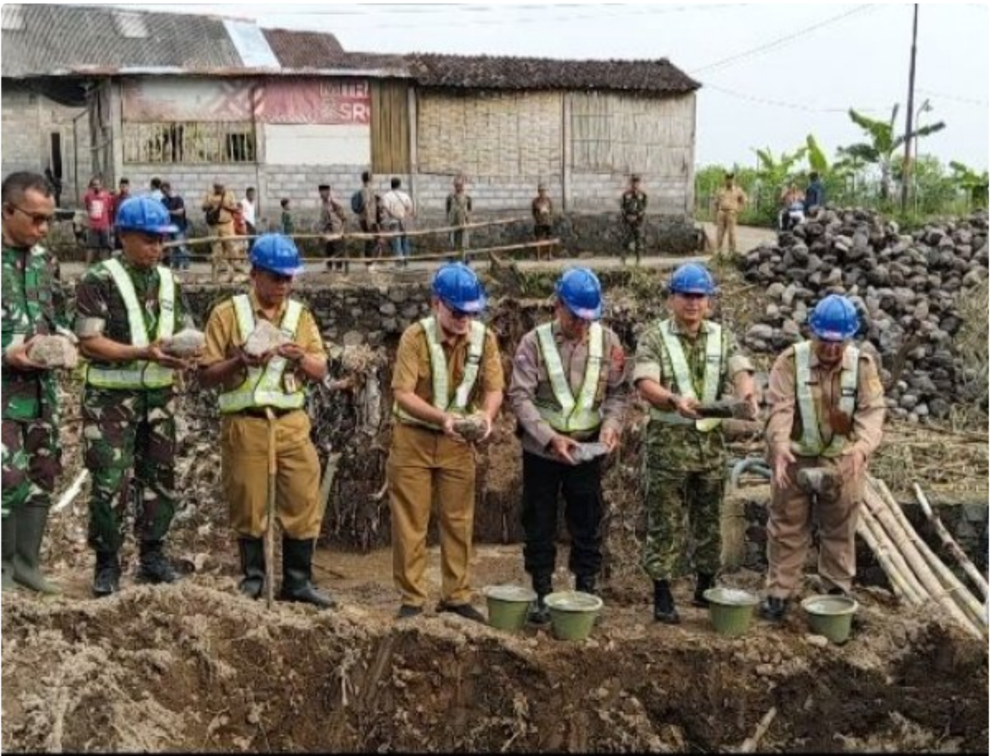
(Foto Dokumen) : Peletakan batu pertama pembangunan jembatan di Desa Pucangrejo
