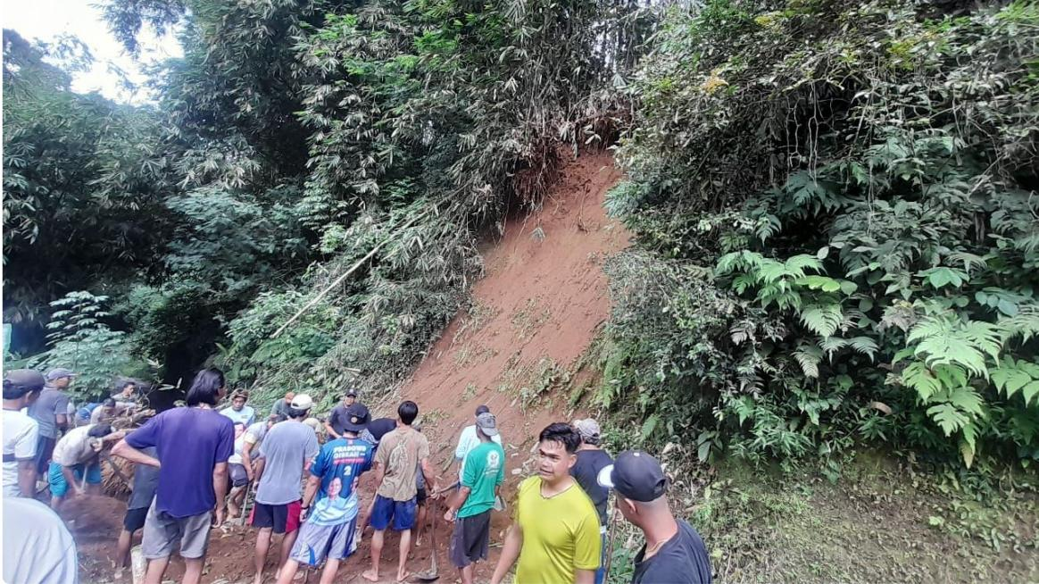
Intensitas curah hujan yang cukup tinggi mengakibatkan tanah setinggi 6 meter, lebar 5 meter berakibat longsor ke jalan sehingga menutupi akses jalan warga.
